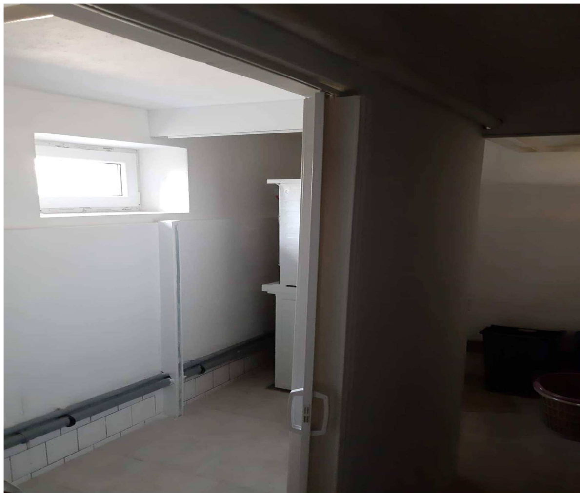
Stavebné úpravy práčovne
